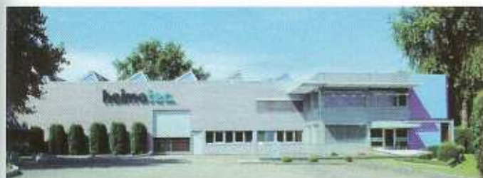
Der Eingangsbereich der heimatec GmbH in der Carl-Benz-Straße 4 in Renchen
