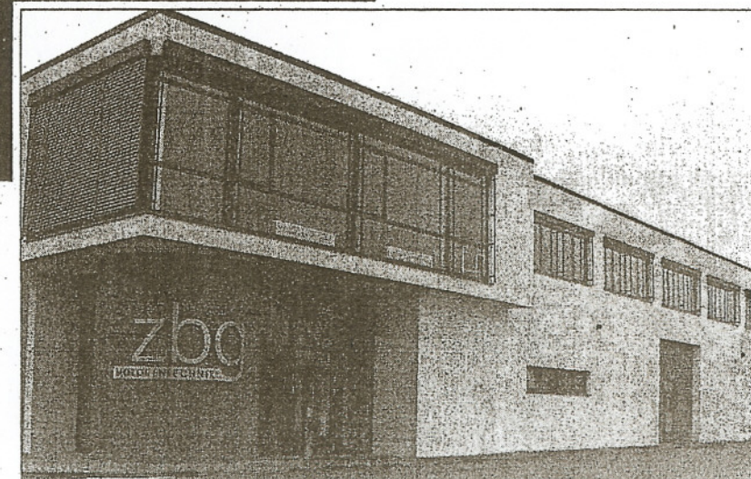
Innerhalb von sechs Monaten wurde die neue Produktionshalle errichtet. Foto: dt
