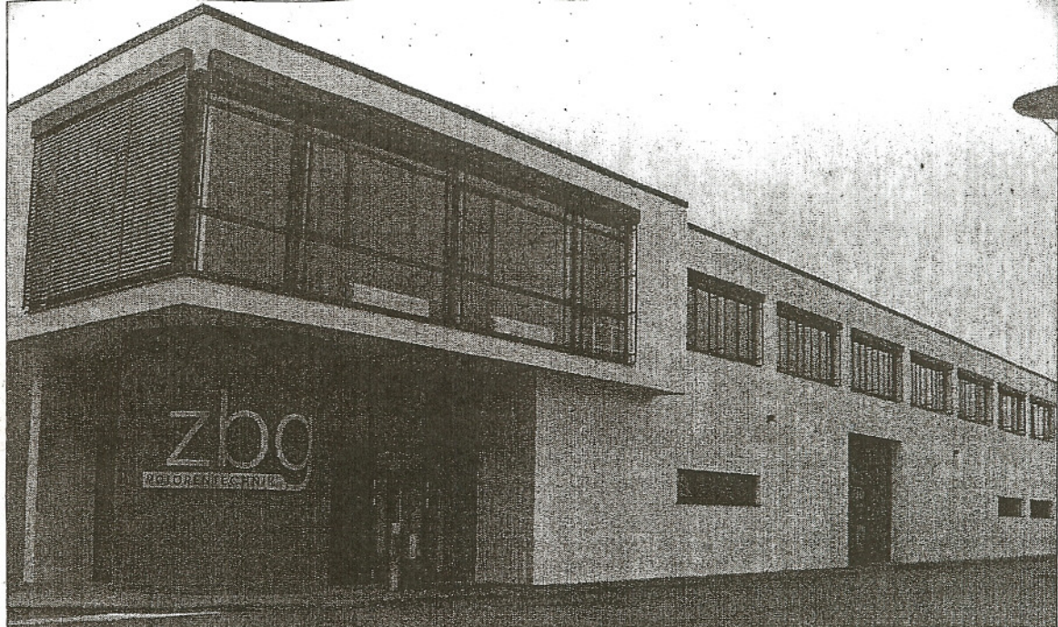
Das neue Gebäude der Firma ZBG Motorentechnik vereinigt Verwaltung und Produktion unter einem Dach.
